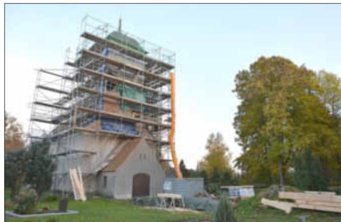
Wie Sie erkennen können, geht es mit der Turmsanierung in Boldekow voran. Die Bauarbeiten gestalten sich als sehr kompliziert, da der Turm nicht zu stark be- oder entlastet werden darf. Sonst fällt er um. Nun ist die Westseite wieder sicher. Hoffentlich hält das Wetter, um die Arbeiten erfolgreich voranzubringen. Somit grüße ich Sie von „unserer“ derzeitig größten Baustelle im Sprengel!
