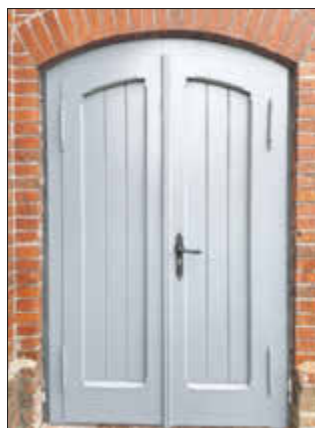
Bauabnahme der Zimmererarbeiten in Boldekow
